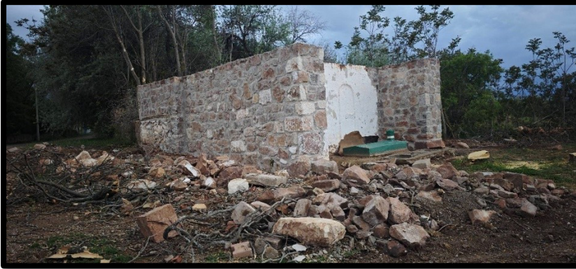
Görsel 6: Dedebağı'nda Arıcı Baba Türbesi Restorasyonu Süreci (Proje Arşivi)
